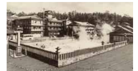
草津温泉にあるほとんどの源泉が50℃以上の高温で、山の中に湧く万代鉱源泉にいたっては95℃とあまりに高温のため温度を下げています。その過程でできる真湯を町内に給湯したり、公共施設の暖房や道路の融雪のためにも有効活用しています。
